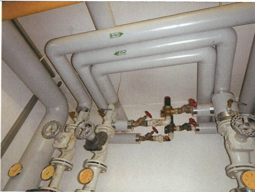
Tlw. lückenhaft gedämmte Wärmeverteilungsleitungen im unbeheizten Keller
