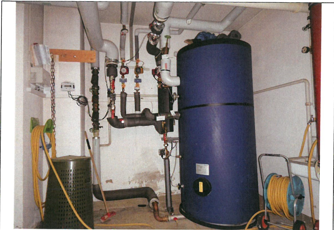
Zentrale Brauchwassererwärmung
