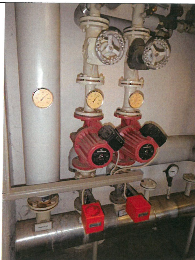
Tlw. lückenhaft gedämmte Wärmeverteilungsleitungen der Pumpenstation
